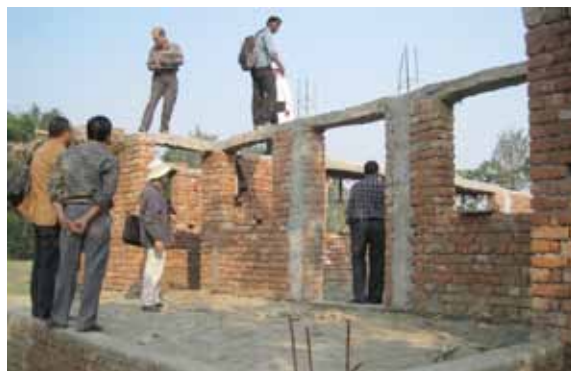
コミュニティーセンターの建設現場
